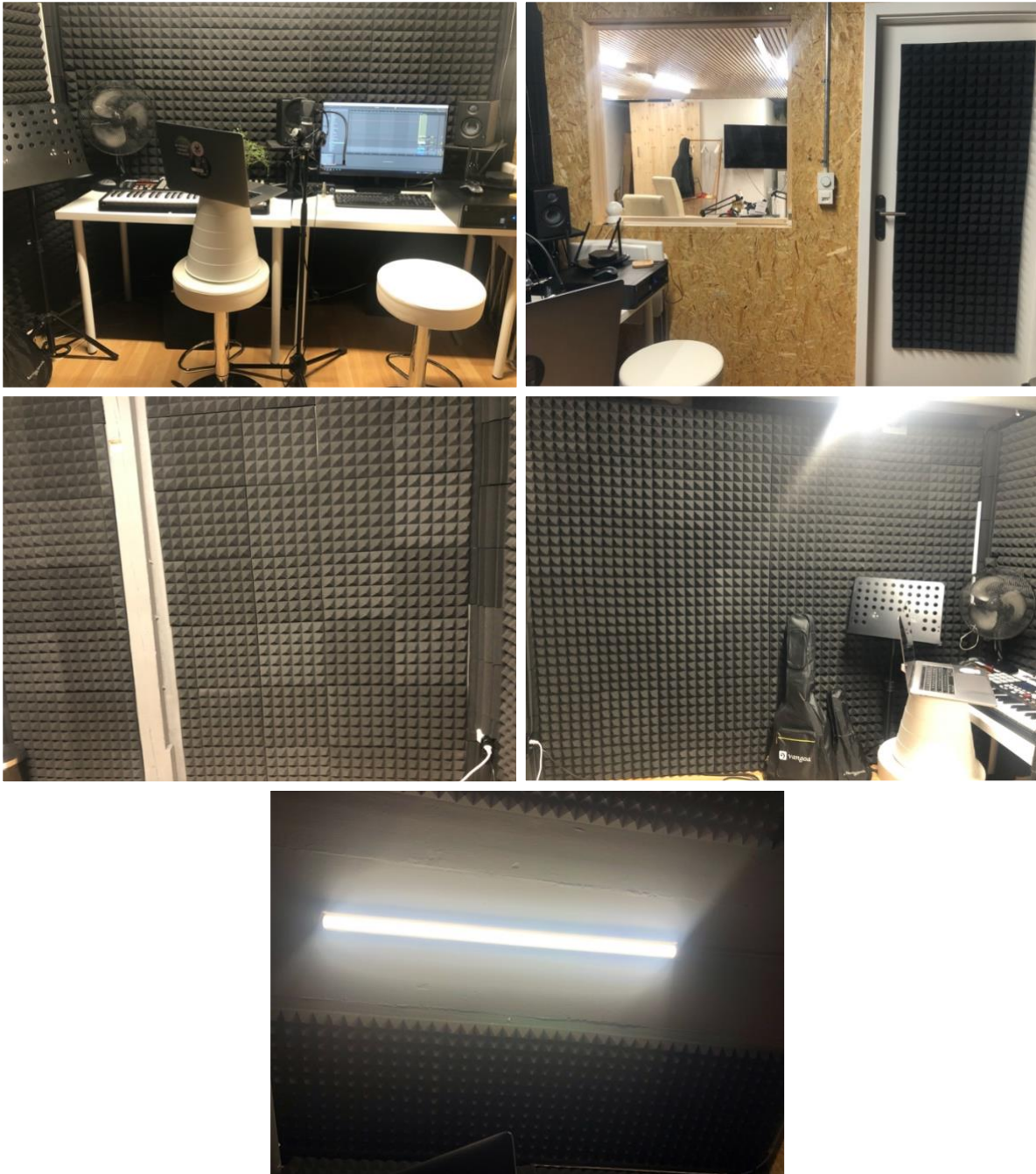
Fotografie der Wände und der schallschluckenden Elemente des Tonstudios.
